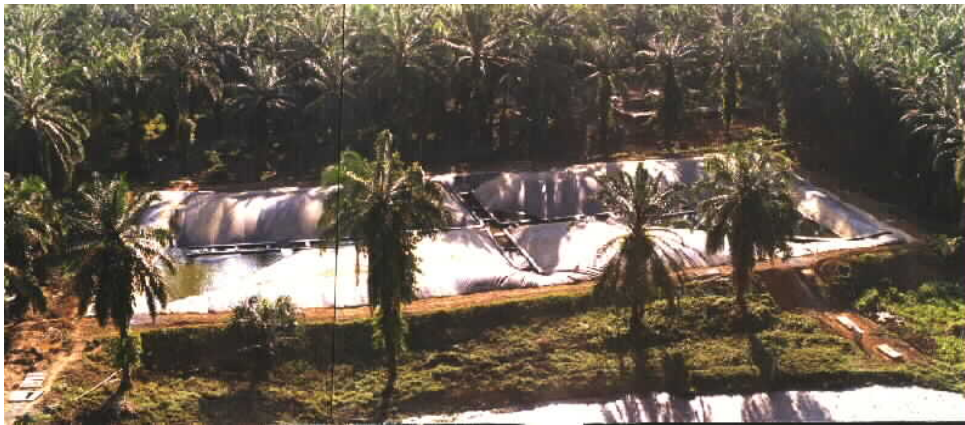
Abbildung 11-11 Abgedeckte anaerobe Teiche in einem Palmöl-Betrieb /77/
