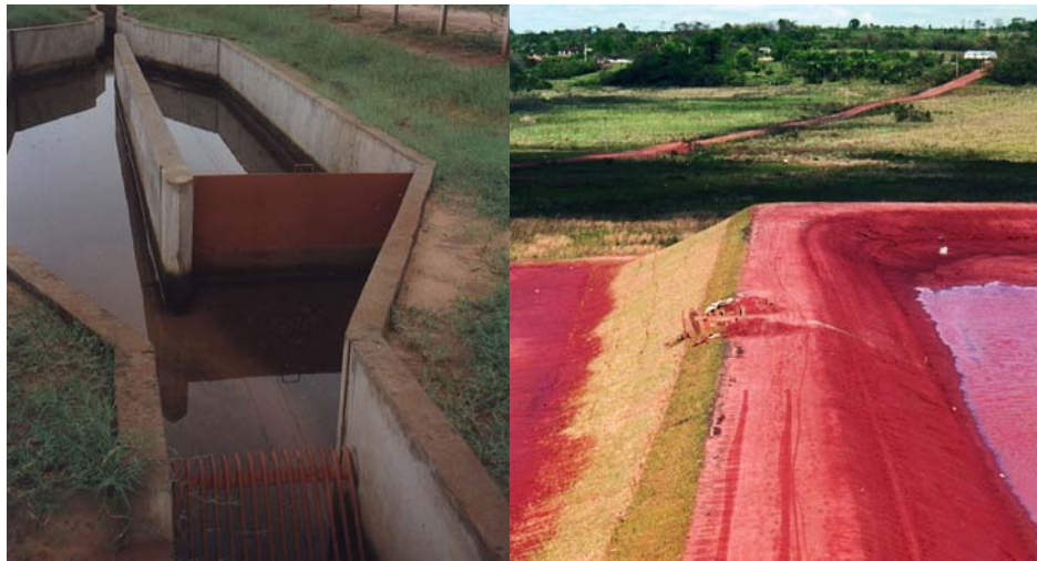
Abbildung 14-1 Sandabscheider und Klärteich für ca. 30.000 EW
