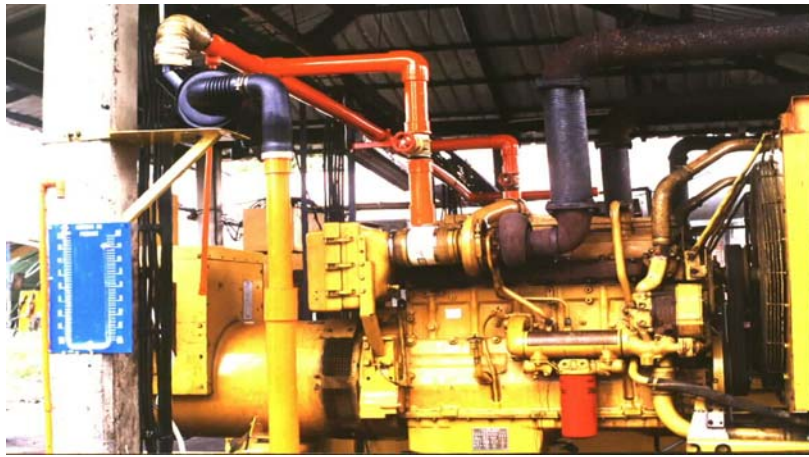
Abbildung 12-1 „Dual-fuel“ Dieselmotor in einem Palmöl-Betrieb /77/
